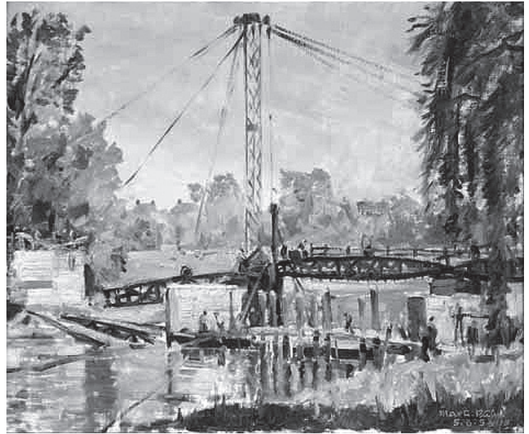
"Alte Mangfallbrücke in Rosenheim" 5.8.1953 Max A. Kuhn 1895 Landshut - 1974 Mallersdorf-Pfaffenberg
